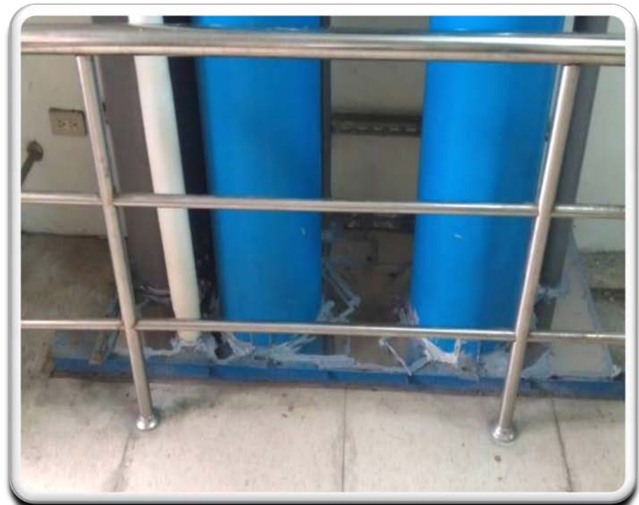
管線貫穿垂直防火區劃處以鋼板等材質填塞
