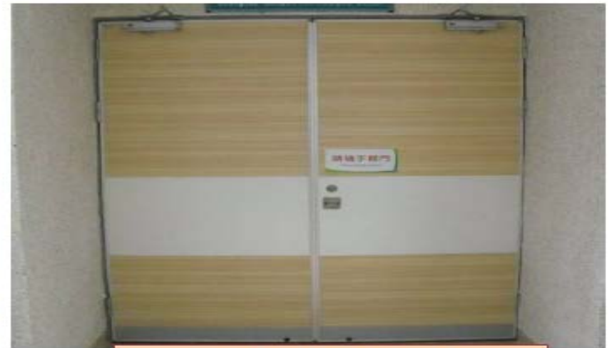
常閉式防火門
