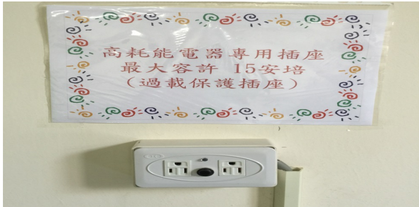
高耗能電器更換為 過載 自動斷電之插座
