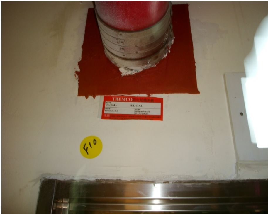
管線貫穿水平防火區劃處以防火泥填塞
